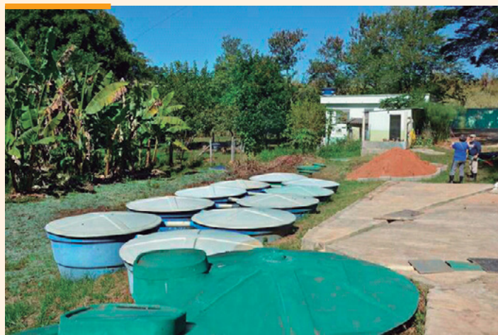
Fossa séptica e filtro anaeróbio, decantador secundários e bananeiras ao fundo, que recebem o composto orgânico das fezes e o lodo diferido de todo o sistema
