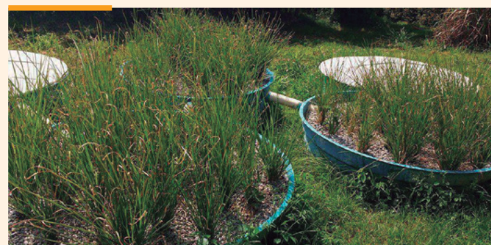
Sistemas alagados construídos para remoção de nutrientes com capim-vetiver, instalados neste ano
