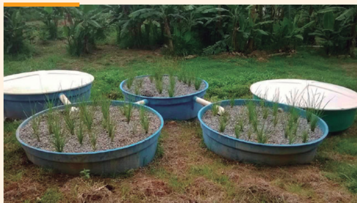
Fossa séptica e filtro anaeróbio, decantador secundários e bananeiras ao fundo, que recebem o composto orgânico das fezes e o lodo diferido de todo o sistema
